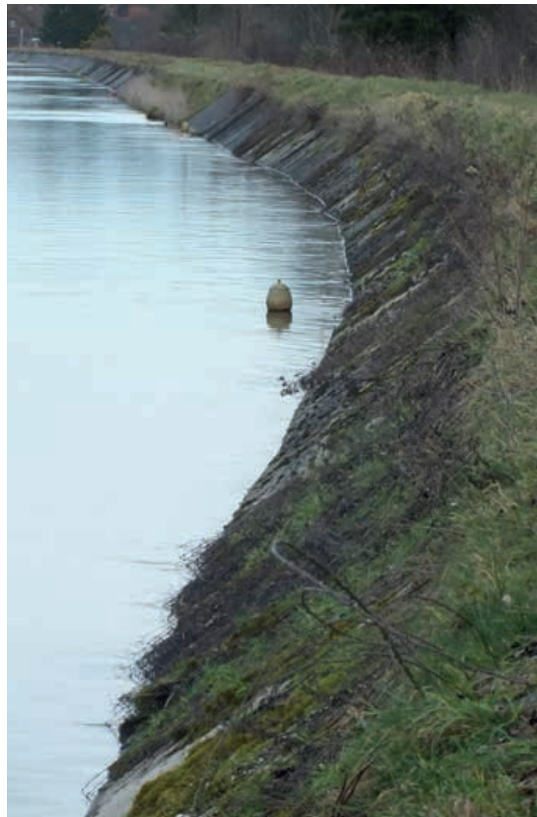
Einen Meter hoch ist das gemauerte Ufer des Isarkanals.
